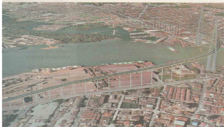
rampa de acesso à ponte, no lado de Santos, começará no Canal 6 e seguirá pela Avenida Mário Covas
